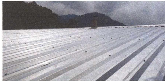
Foto 2: COLOCACION DE CUBIERTA DE LAMINA TROQUELADA Y ESTRUCTURA PORTANTE EN AULAS TERMINADA
