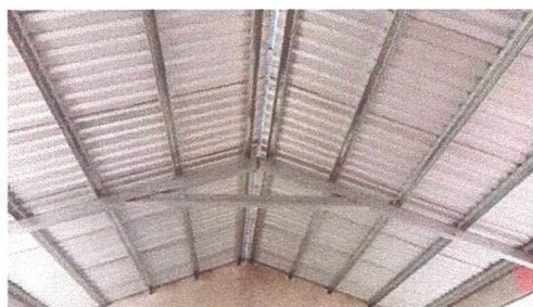
Foto 09: COLCACION DE ESTRUCTURA METALICA GALVANIZADA PORTANTE DE TECHO DE MODULO DE AULAS TERMINADA.
