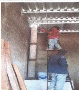
Foto 5: MEJORAMIENTO DE POLLETON Y SUSTITUCION DE CHIMENEA EN AREA DE COCINA TERMINADO
