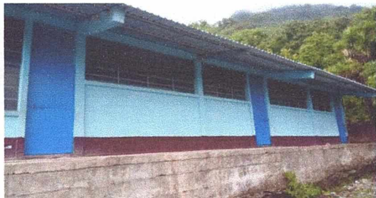
Foto 7: PUERTAS METÁLICAS EN MODULO DE AULAS REPARADAS. SE APRECIA COLOCACION DE LAMINA NUEVA EN AULAS.
