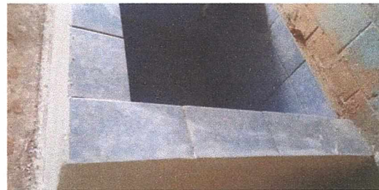
Foto 4: COLOCACION DE PISO CERAMICO EN PARTE INTERIOR Y SUPERIOR DE PILA DE CONCRETO TERMINADO
