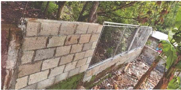
Foto 3: MURO PERIMETRAL CON TUBERIA Y MALLA METALICA TERMINADA
