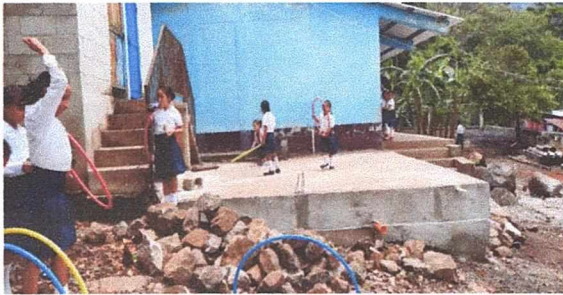
Foto 1: FUNDICION DE CONCRETO TERMINADO BASE FRONTAL DE SANITARIOS
