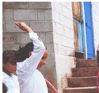
Foto 8: PUERTA METÁLICAS DE ACCESO A UN SANITARIO REPARADA.
