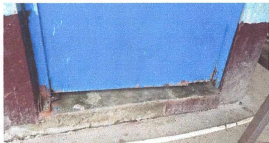
Foto 1: REPARACIONES DE PUERTAS METAL DE MODULOS DE AULAS Y COCINA
