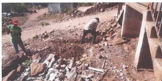
Foto 5: FUNDICIÓN DE CONCRETO PARA EVITAR EL DESPRENDIMIENTO DE LA TIERRA DE LA BASE FRONTAL DE LOS SANITARIOS
