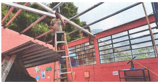
Foto 2: REPARACION DE TECHO
