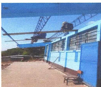
Foto 3: REPARACION DE ESTRUCTURA PORTANTE EN AULAS
