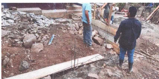
Foto 4: MURO PARA LA CONTENCIÓN DE TIERRA DE MODULO DE SANITARIOS
