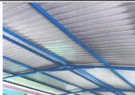
Foto 2: TECHO CON ESTRUCTURA METALICA
