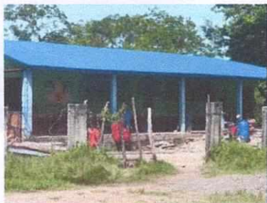
Foto 1: LAMINA Y COSTANERAS PARA EL TECHO INSTALADA
