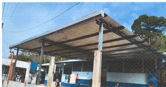
Foto 2: techo de cancha finalizado
