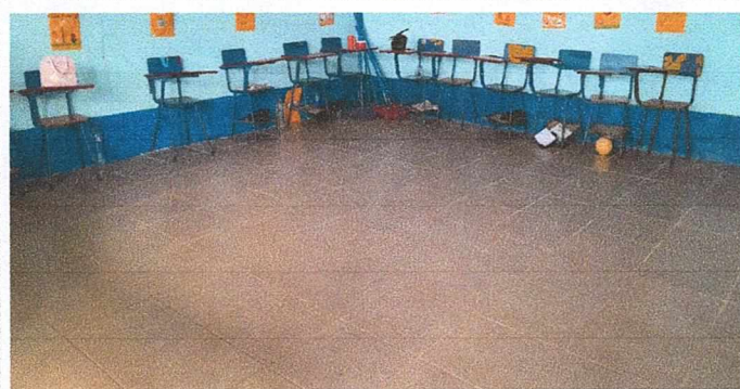
Foto1: Piso de salón finalizado
