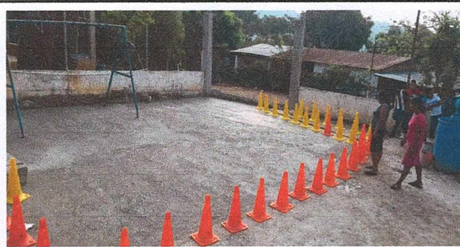
Foto 4: Loza de patio finalizado
