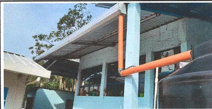
Foto 5: Instalación de canales
