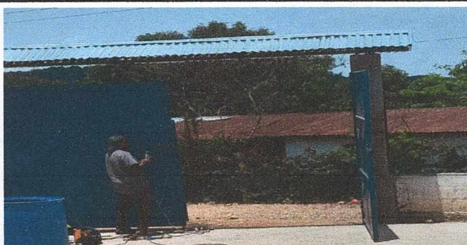
Foto 6: reparación portón finalizado
