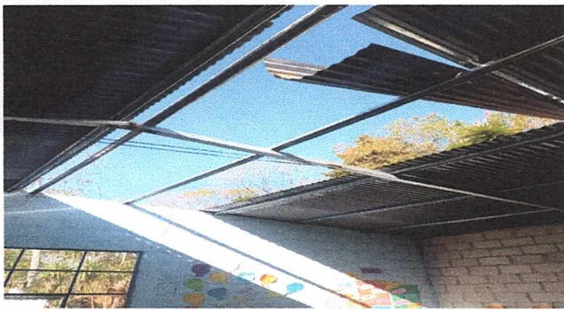
Foto 3: remozamiento de techo
