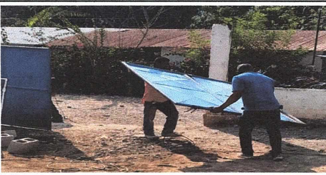
Foto 5: reparación de portón
