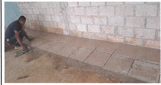
Foto 4: Pegado de piso
