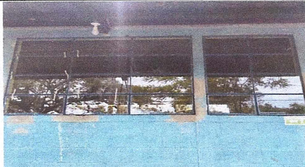
Foto 4: Ventanas completas en su instalación
