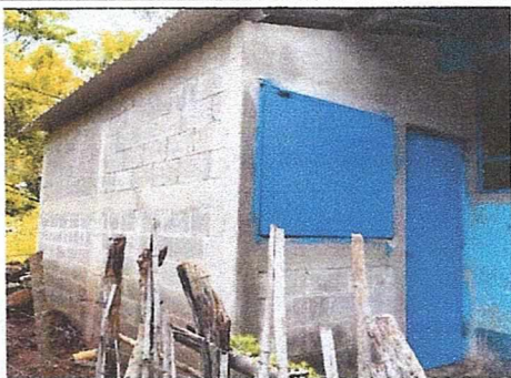
Foto1: El mejoramiento de paredes, ventana y puerta de la cocina completo para el buen ambiente y seguridad para preparar los alimentos escolares.
