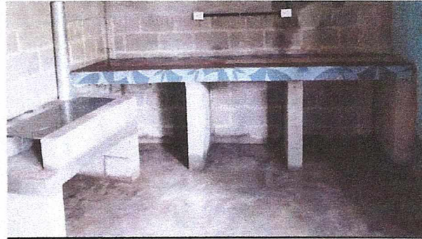
Foto 2: Área de cocina completa de piso, polleton y mesa para la preparación de alimentos.
