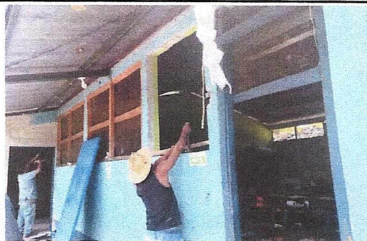
Foto 4: Instalación de las Ventanas en un 50%
