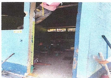
Foto 3: En un 50% de instalación de la Puerta del salón de clases.
