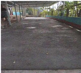
Foto 5: LOSA DE PATIO
