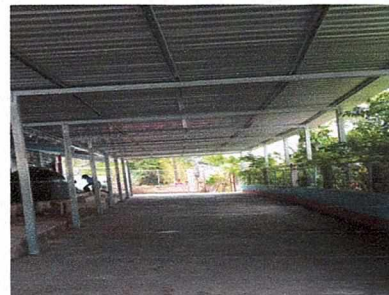
Foto 6: LOSA DE PATIO
