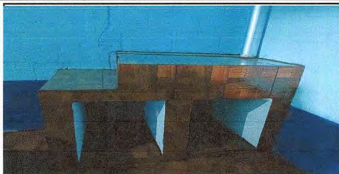
Foto1: Construcción de polletón: plancha metálica, chimenea, cerámica
