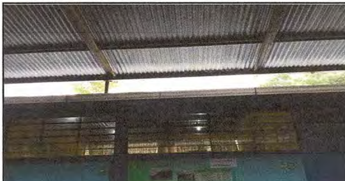
Foto 2: Sustitución de canales
