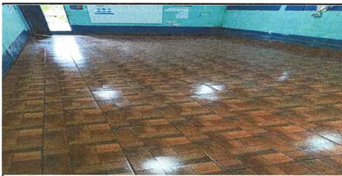
Foto 6: Sustitución de piso aula de segundo A
