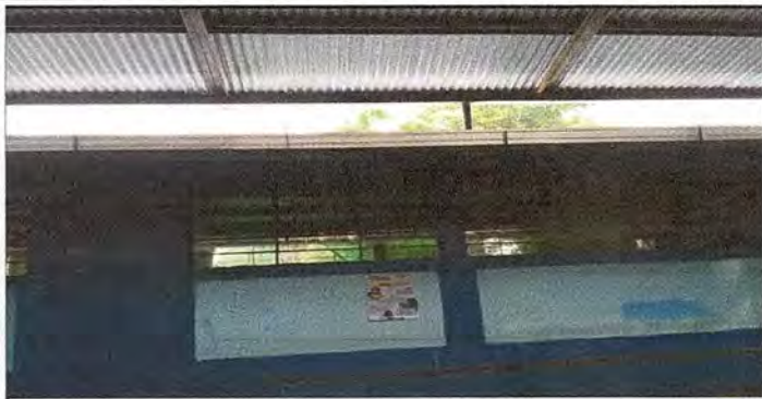
Foto1: Sustitución de canales
