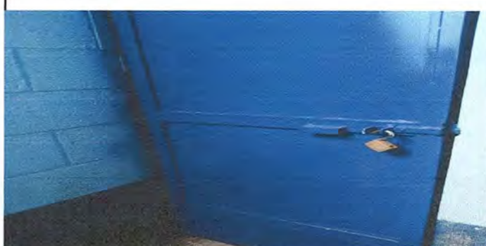
Foto 2: Pintura de puertas
