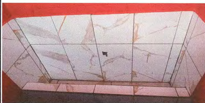
Foto 1: Reparación de mingitorio
