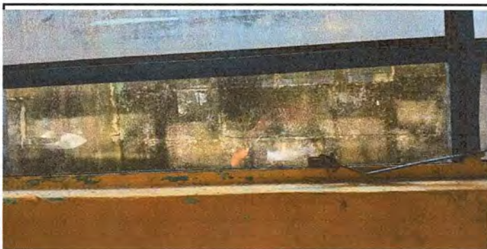
Foto 5: Sustitución de ventanas
