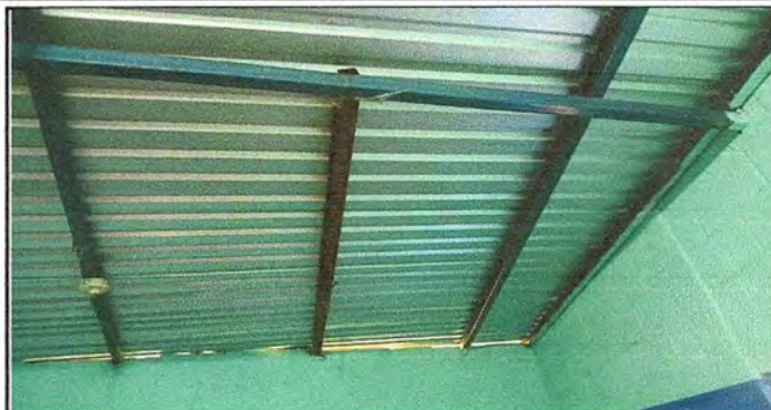
Foto 2: Sustitución de lámina por lámina troquelada
