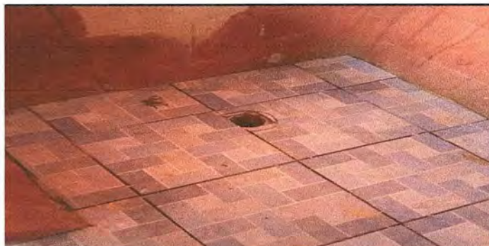
Foto 6: Sustitución de sanitario
