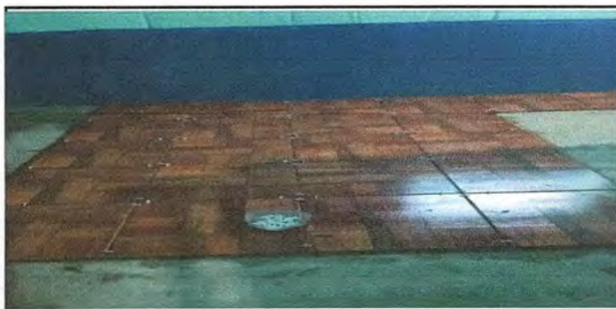
Foto 5: Sustición de piso
