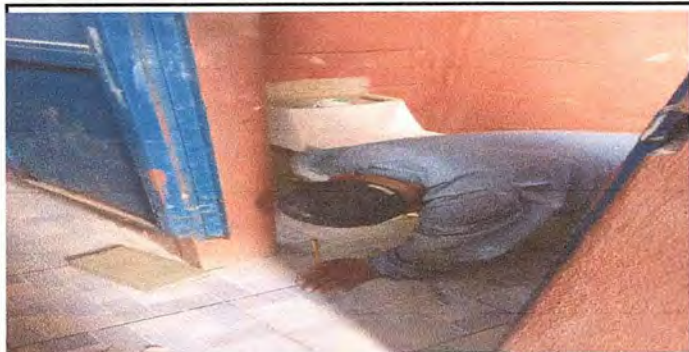
Foto 3: Sustitución piso baños
