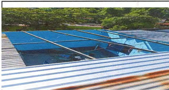
Foto 2: Sustitución de lámina por lámina troquelada
