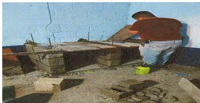
Foto1: Construcción de polletón: plancha metálica, chimenea, cerámica
