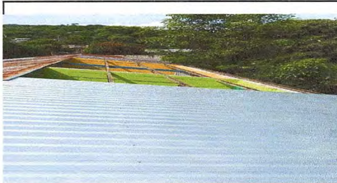
Foto 4: Sustición de lámina por lámina troquelada
