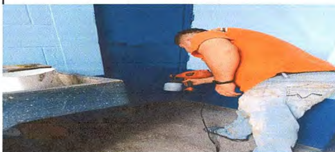
Foto 2: Pintura de puertas
