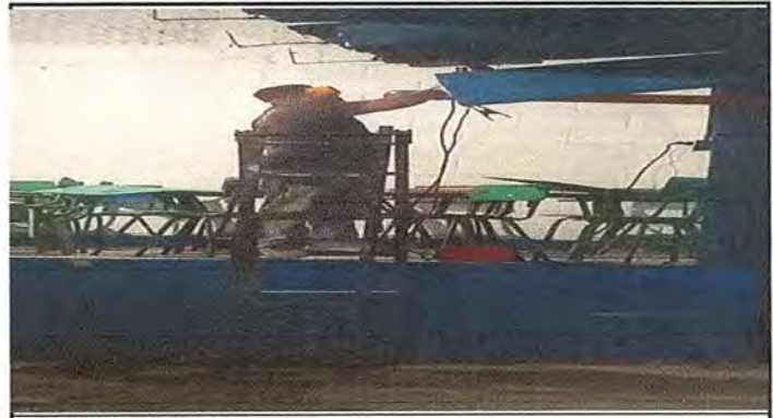
Foto 2: Sustitución de canales
