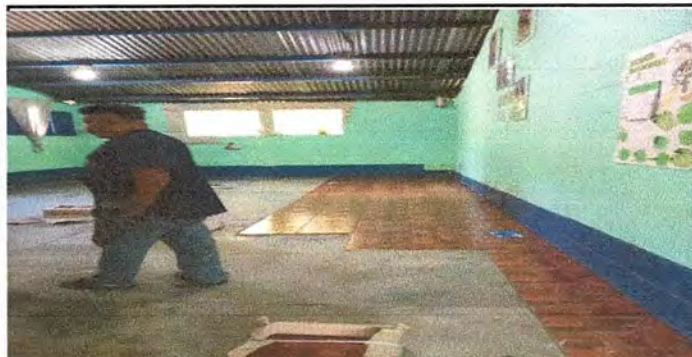
Foto 6: Sustitución de piso aula de segundo A
