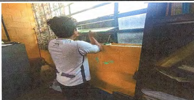
Foto 5: Sustición de ventanas
