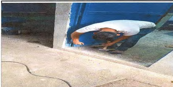
Foto 3: Cambio de puerta de lugar: quitar, colocar, pintar
