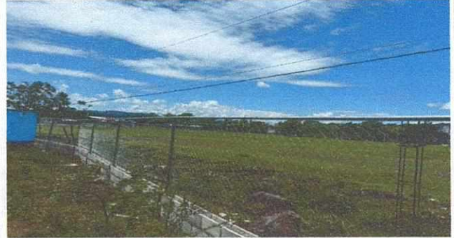
Foto 2: Modulo muro perimetral terminado parte del campo
