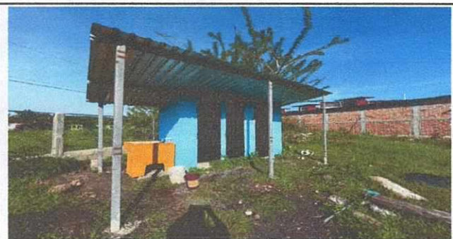
Foto 5: Modulos Baños galera terminada
