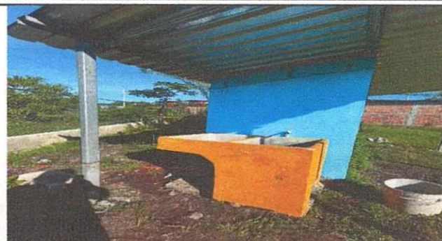
Foto 2: Módulo baños: Instalación de pila
