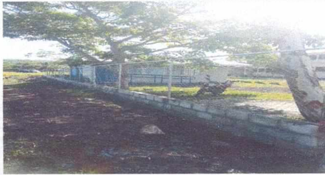
Foto 1: Modulo muro perimetral terminado parte de enfrente
