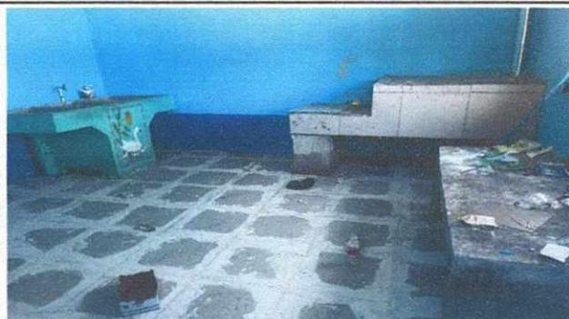
Foto 4: Modulo cocina cambio de torta a piso
