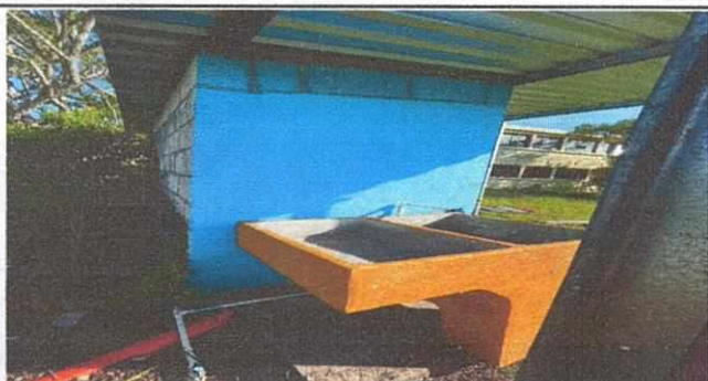
Foto1: Módulo Baños: Instalacion de drenages y agua
