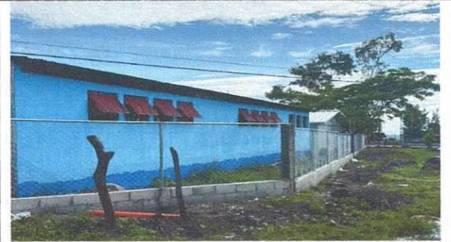
Foto 4: Modulo muro perimetral terminado parte derecha
