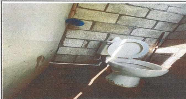
Foto 4: Módulo baños instalacion de agua
