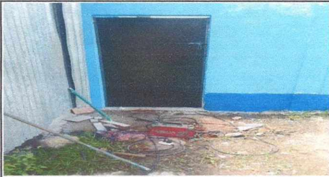
Foto 3: Modula cocina cambio de puerta
