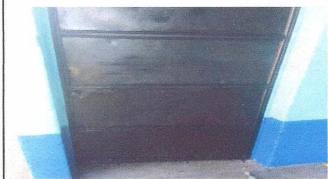
Foto 2: Modulo Aulas: pintura de puerta bodega
