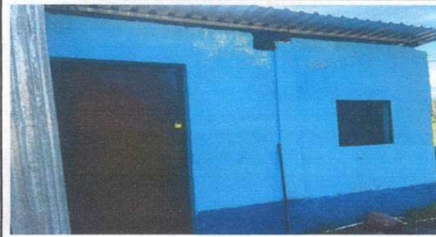
Foto1: Modulo cocina: Ssustición de balcon
