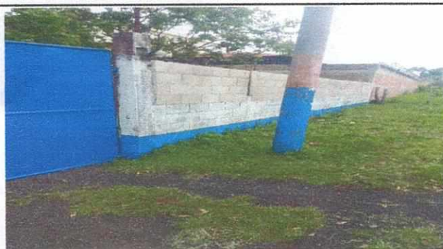
Foto 3: Modulo porton: finalizado
