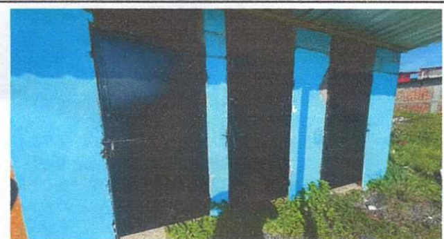
Foto 3: Modula baños instalación de puertas
