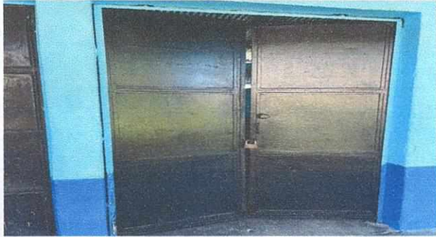
Foto 1: Modulo Aulas: pintura de puertas
