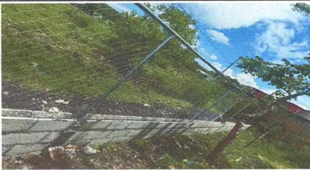
Foto 3: Modulo muro perimetral terminado parte de atrás
