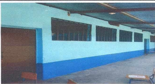
Foto 3: Modulo Aulas: pintura de aulas
