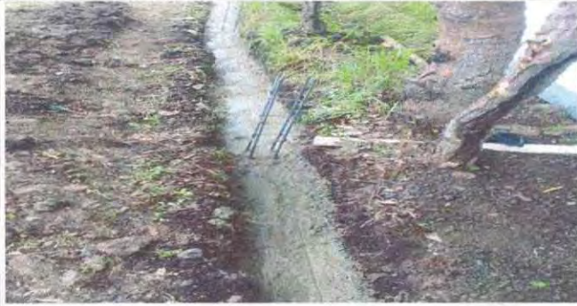
Foto 1: Modulo muro perimetral: cimient
