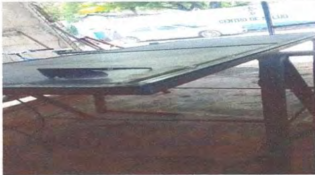
Foto1: Modulo porton: Construccion de porton
