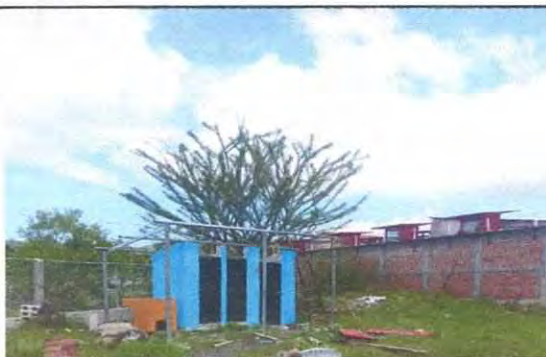
Foto 3: Modula baños colocacion de pila
