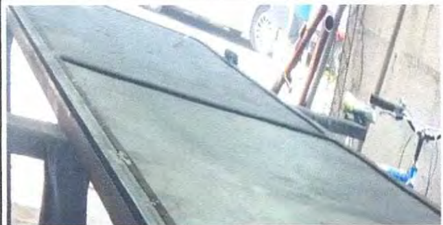
Foto 2: Modulo porton: Construccion de porton
