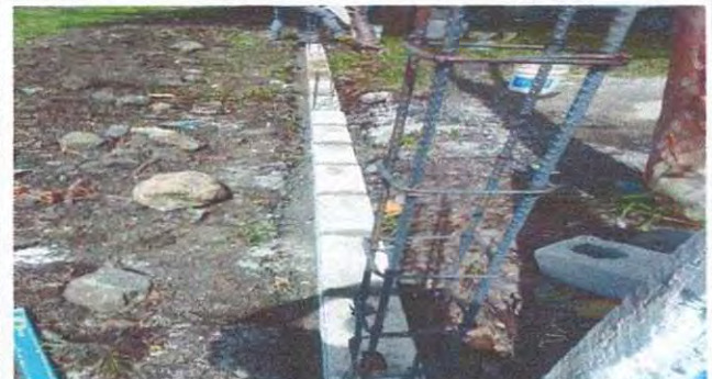
Foto 2: Modulo muro perimetral pegado de block
