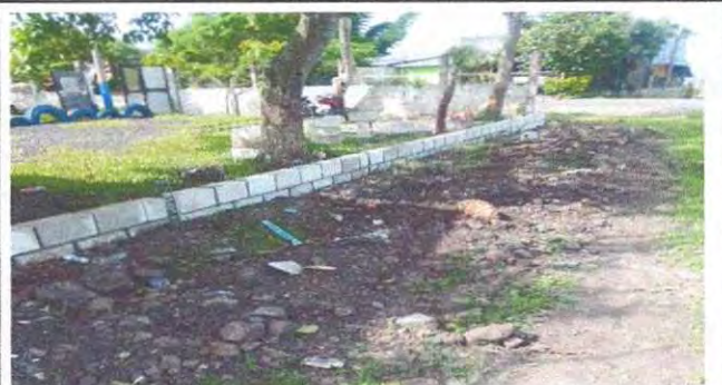
Foto 4: Modulo muro perimetral: pegado de block parte del campo.
