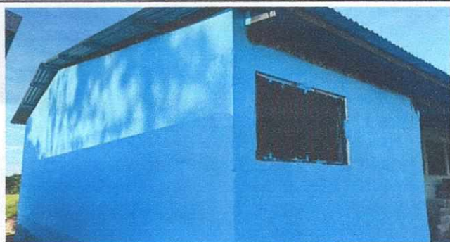
Foto 3: Modulo Aulas: pintura bodega
