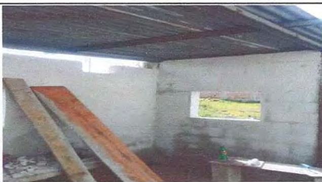
Foto 4: Modulo cocina cambio de techo
