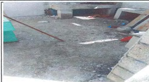
Foto 1: Modulo cocina: Torta de cemento
