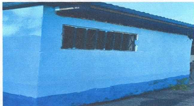
Foto1: Modulo Aulas: pintura
