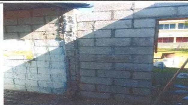
Foto 2: Modulo Cocina. Ampliación de pared
