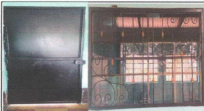
Foto 2: mantenimiento de puertas mas chapas y balcones
