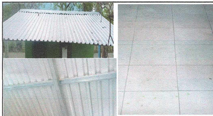
Foto 3: Sustitucion de estructura metalica, lamina y torta por piso en la cocina
