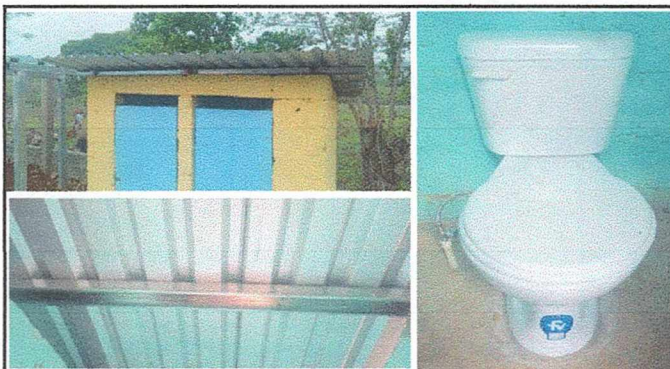
Foto 4: Sustitucion de estructura metalica, lamina y un sanitario
