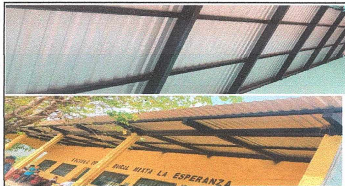
Foto1: Sustitucion de lamina y mantenimiento de estructura de aula
