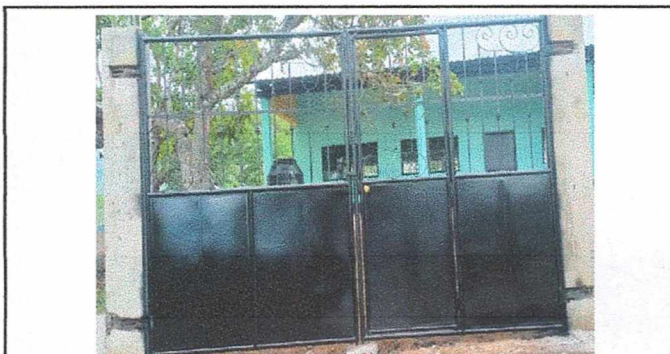
Foto 6: Sustitucion de porton
