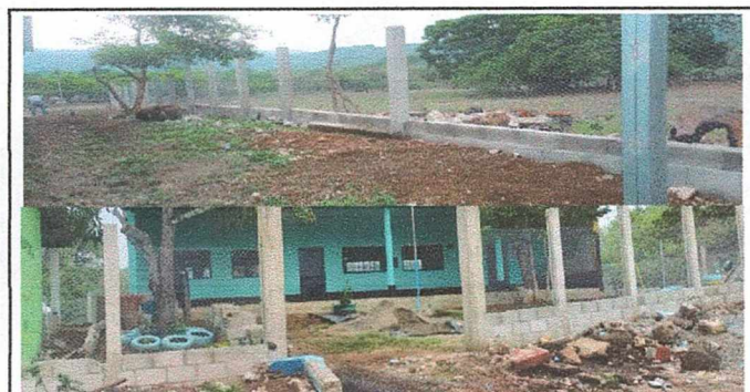
Foto 5: Sustitucion de muro y malla
