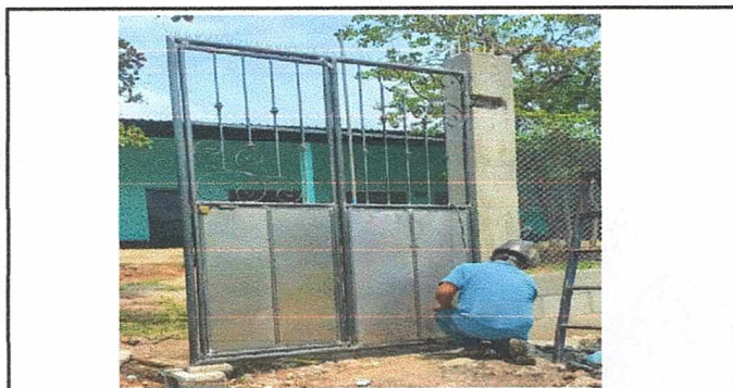
Foto 6: sustitución de portón
