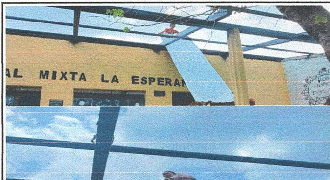
Foto 1: Sustitución de lámina y mantenimiento de estructura de aula
