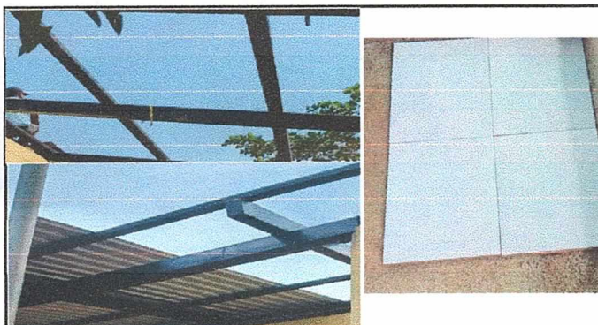
Foto 3: Sustitución de estructura metálica, lámina y torta por piso en la cocina.
