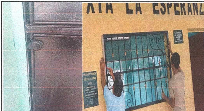
Foto 2: Mantenimiento de puertas, chapas y balcones
