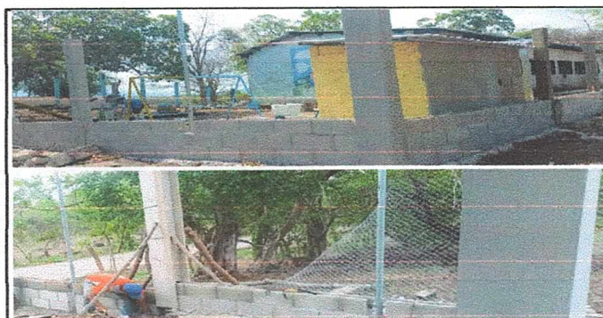
Foto 5: Sustitución de muro y malla
