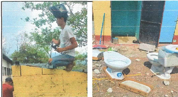
Foto 4: sustitución de estructura metálica, lámina y un sanitario
