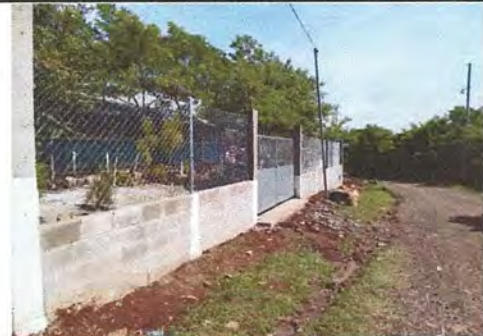
Muro Perimetra con Porton
