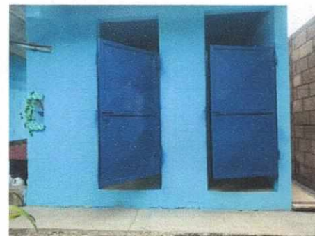
Foto 6: puertas de sanitarios
