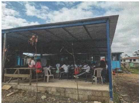
Foto1: Cubierta de lámina y losa de patio
