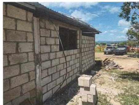
Foto 6: paredes de cocina
