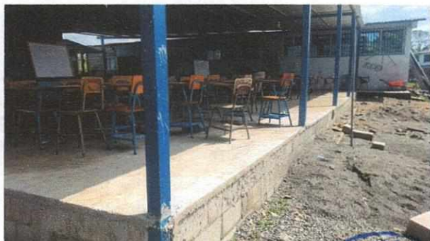
Foto 5: losa de patio
