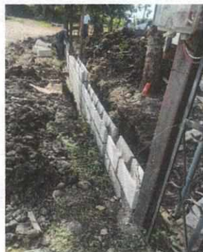
Foto 1: cimentación block para cerca
