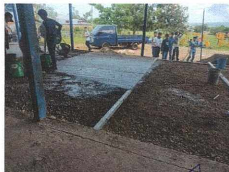
Foto 6: fundición de losa
