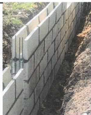
Foto 5: cimentación cerca de electromalla
