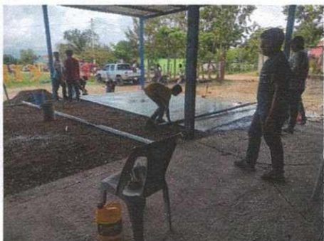
Foto 5: losa de patio
