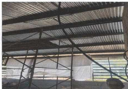
Foto 1: sistema de iluminación
