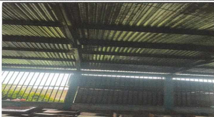
Reparación de iluminación
