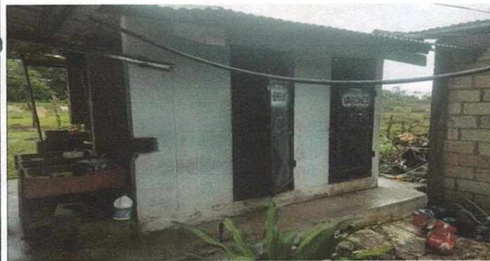
Reparación de puertas de sanitarios
