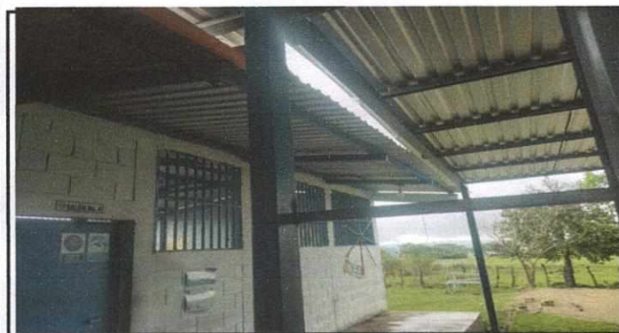
Reparación de canales
