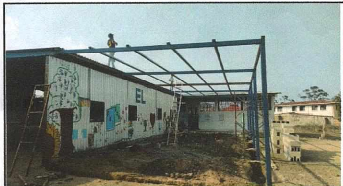
Cubierta de lámina area de patio
