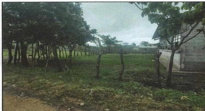
sustitución de cerco de alambre por electromalla con cimentación de block
