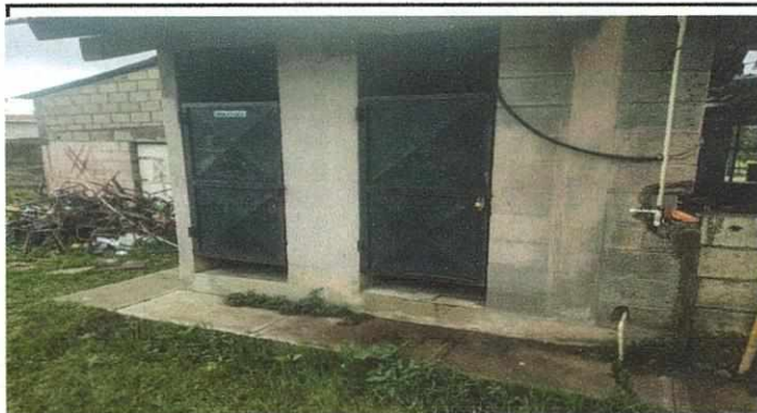
Reparación de sanitarios
