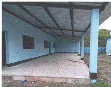
FoSustitución de de estructura metalica, lámina troquelada
