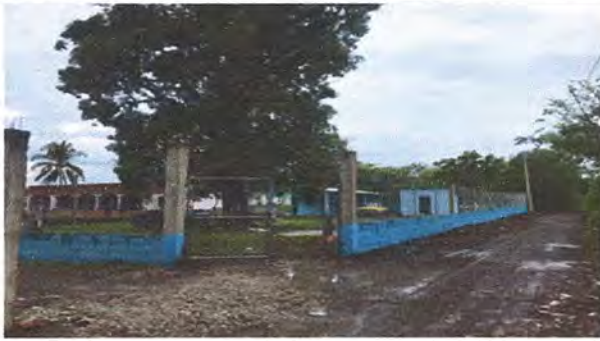
Foto1: Sustitución de muro y malla
