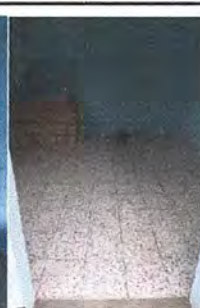
Foto 4: Sustitución de torta por piso ceramico en aulas, cocinas y corredor
