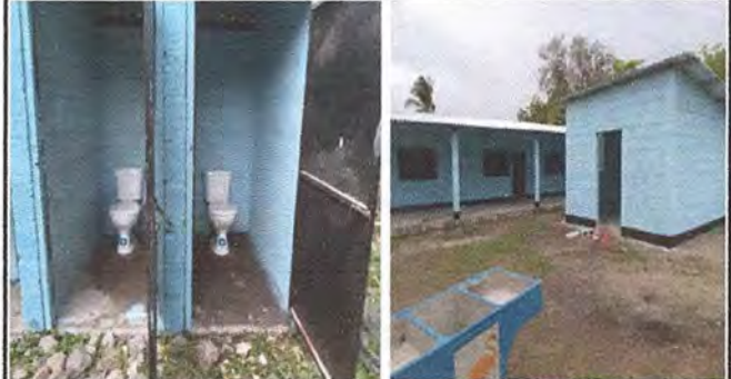
Foto 2: Pintura en muros exteriores e interiores
