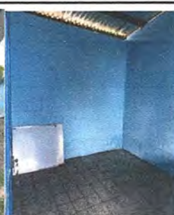
Foto 4: Sustitución de torta por piso ceramico en aulas, cocinas y corredor
