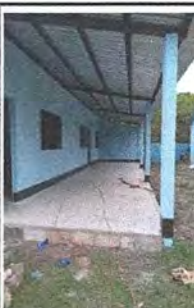
Foto 4: Sustitución de torta por piso ceramico en aulas, cocinas y corredor
