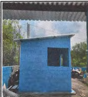
Foto 3: Pared de block, mejoramiento de polleton, e instalación de plancha
