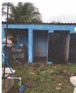
Foto 3: Pintura en muros exteriores e interiores
