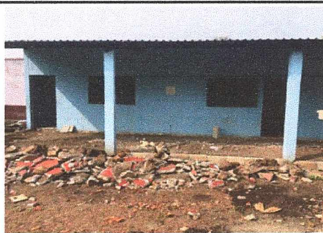
Foto 4: Sustitución de torta por piso, en aulas, cocinas y corredor.
