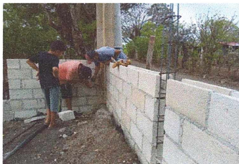
Foto1: Sustitución de Muro y malla
