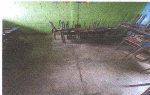
Foto 2: Piso de Cocina y 2 aulas
