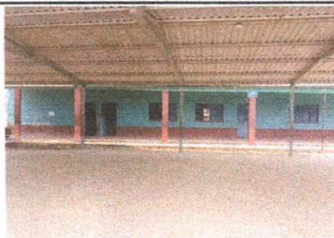
Foto 6: Pintura del establecimiento
