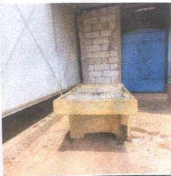
Foto 5: Reparación de Pila y tubería de agua potable.
