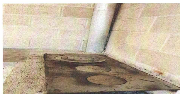
Foto 2: Sustitución de estufa rural con chimenea y plancha de metal
