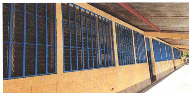
Foto 3: Fabricación e instalación de balcones de metal
