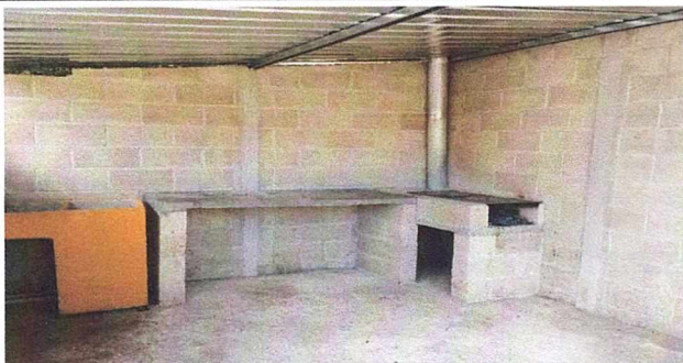
Foto 1: Reparación de cocina, mueble de cocina
