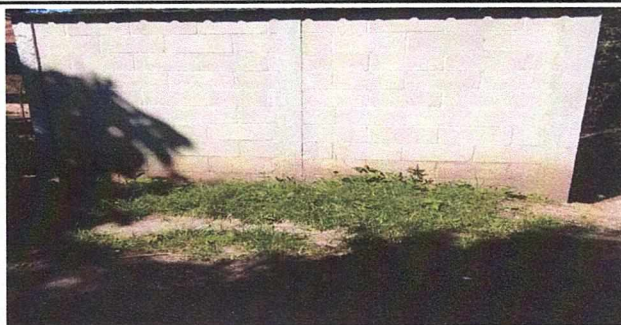
Foto 5: Muro perimetral, reparación de muro perimetral de block
