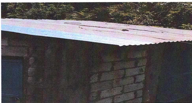
Foto 2: Cubierta de lamina, sustitución de lamina tronquelada auliznc calibre 26
