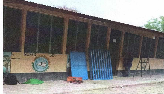
Foto 3: Fabricación e instalación de balcones de metal
