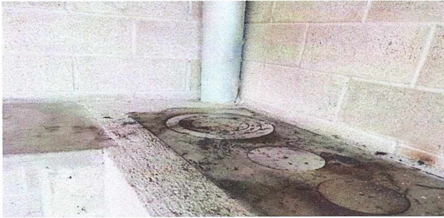
Foto 1: Reparación de cocina, mueble de cocina
