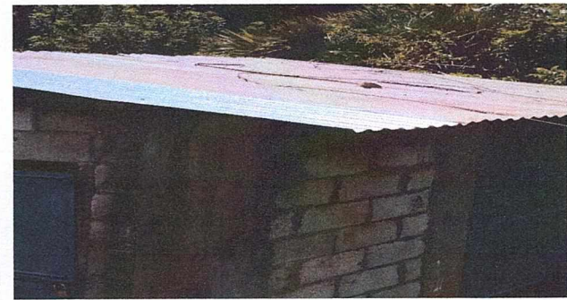
foto 2: Cubierta de lamina, sustitución de lamina tronquelada auliznc calibre 26
