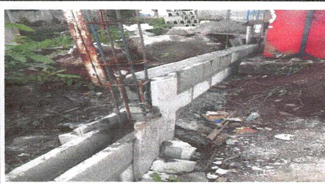
NOTA: mejoramiento de muro perimetral parte 2
