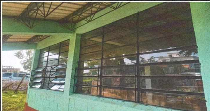
2 limpieza de ventanas y sustitución de vidrios
