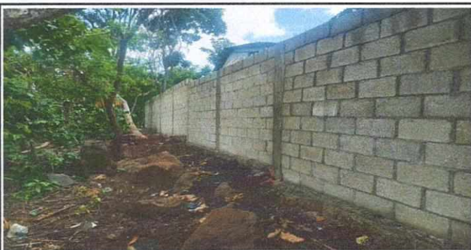
foto 5 reparacion de muro perimetral
