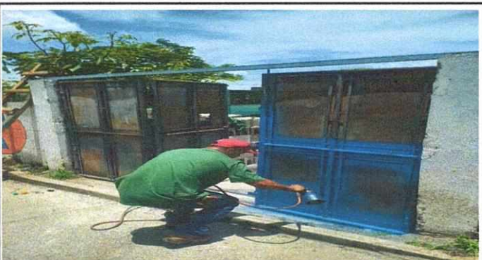
Foto 3 mantenimiento de porton
