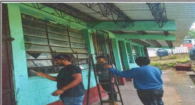
2 limpieza de ventanas y sustitución de vidrios
