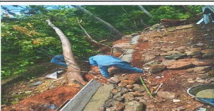
foto 5 reparacion de muro perimetral
