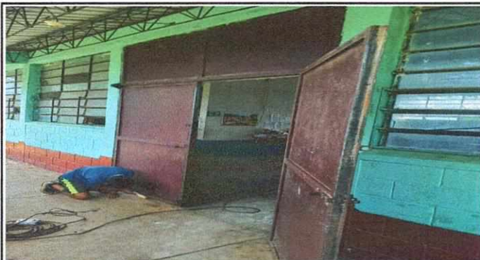
foto 4 mantenimiento a estructura (lijado, cepillado aplicación de pintura)
