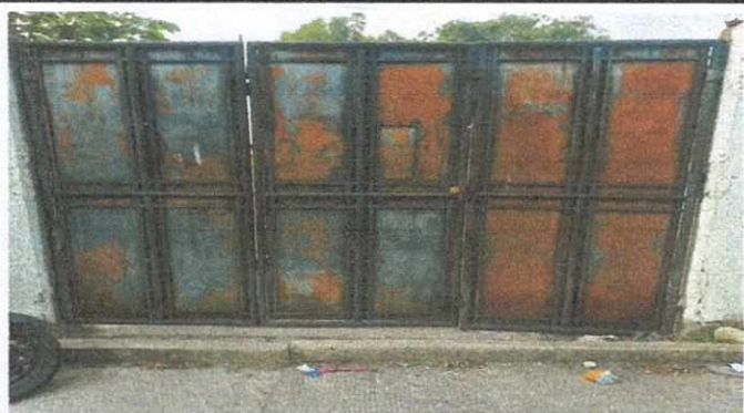
Foto 3 mantenimiento de porton
