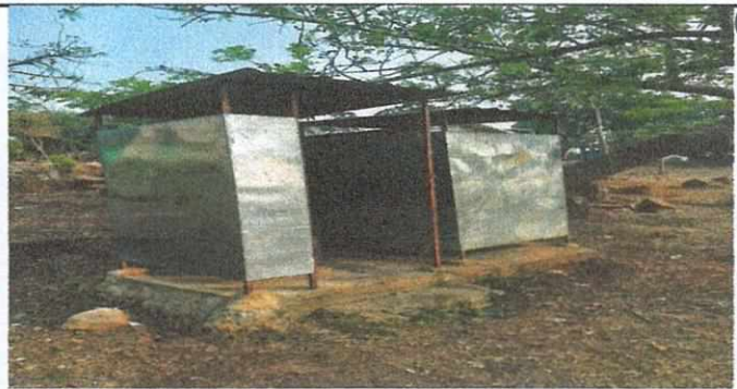
Foto 6 sustitucion de inodoros
