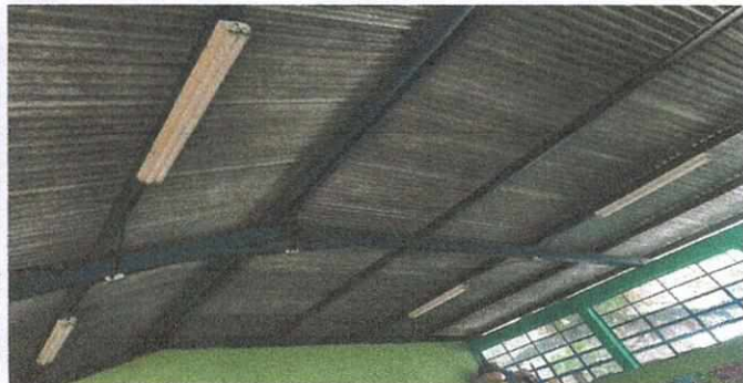
Foto 1 Cambio de focos y plafoneras
