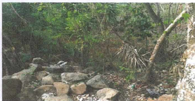
foto 5 reparacion de muro perimetral
