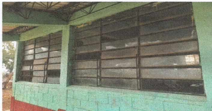
Foto 2 sustitucion de vidrios, mantenimiento de estructura, pintura de muros
