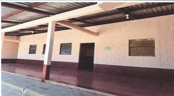
Foto1: Finalización de pintura de interior y exterior de las diferentes aulas del establecimiento.
