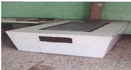
Foto 5: Azulejo y plancha instalados en la cocina del centro educativo.
