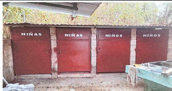
Foto 2: Puertas pintas, identificadas e instaladas en los sanitarios de los alumnos.
