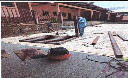
Foto 3: Elaboracion de base para colocar el nuevo tinaco que abastecera con mas agua y limpia.
