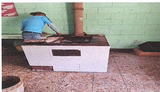
Foto 5: Sustitucion de azulejo y plancha en cocina del centro educativo.
