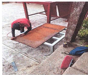
Foto 2: Mantenimiento y luego se pintaran las diferentes puestas de los sanitarios de los alumnos.
