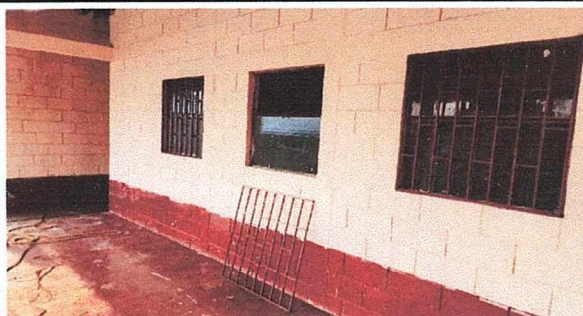
Foto 6: Instalacion de balcones que daran seguridad a los bins del centro educativo.
