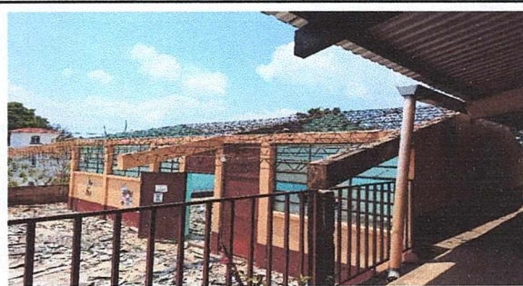
Foto 4: Sustituyendo el techo de duralita por lamina, colocacion de vigas de metas para asegurar mejor el techo nuevo en el aula de parvulos.
