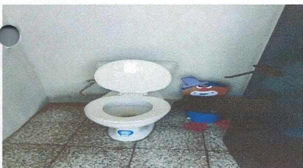
Foto. 5 Instalacion de tasas de china a sanitarios
