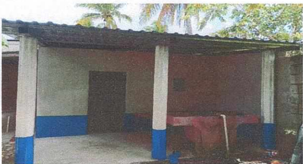
Foto.3 Reparacion de piso de concreto
