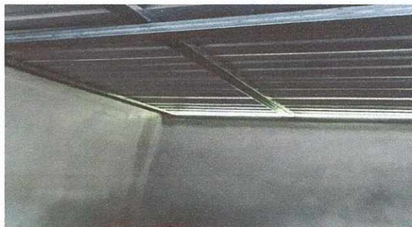
Foto.2 Repello cernido y chimenea a cocina
