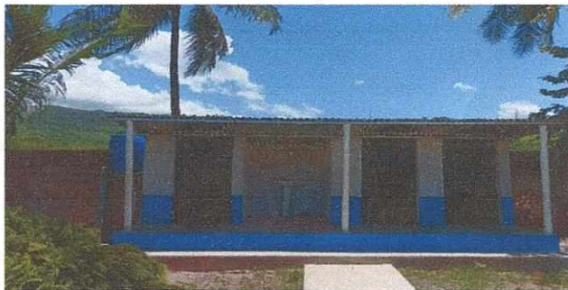
Foto.4 Reparacion de sanitarios y puertas
