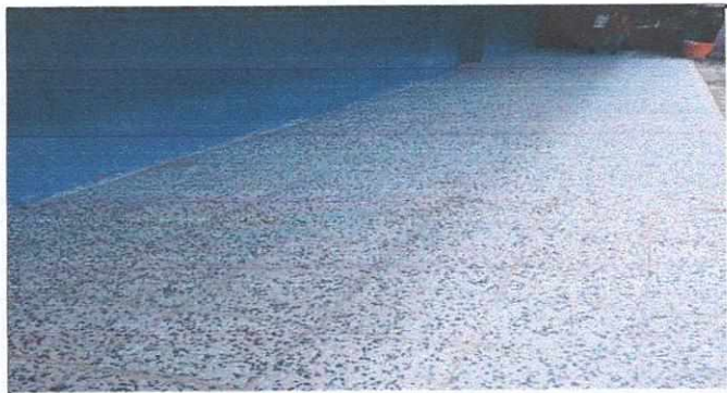
SUSTITUCION DE PISO
