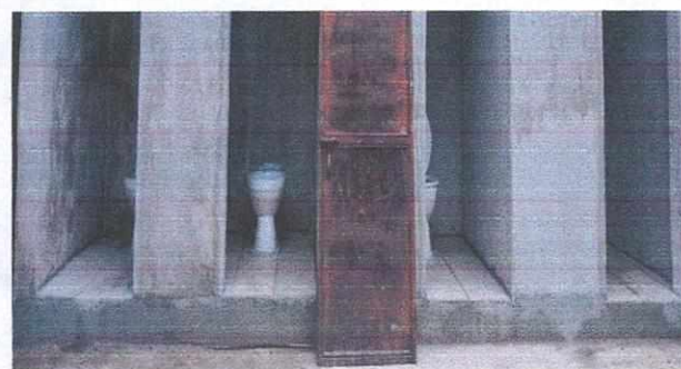
INSTALACION DE PISO EN BAÑOS
