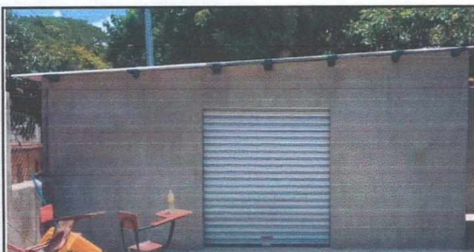
REPARACION DE COCINA
