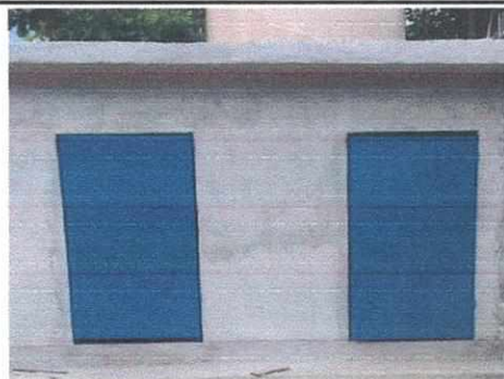
FABRICACION E INSTALACION DE PUERTAS EN BAÑOS
