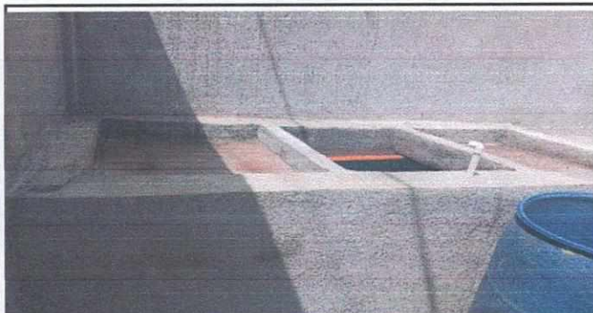
PILA DE DOS LAVADEROS EN COCINA
