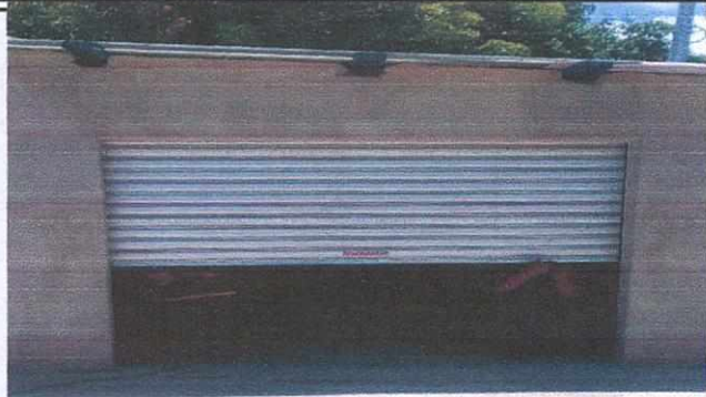
FABRICACION E INSTALACION DE PERCIANA EN COCINA
