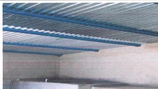
sustitucion de lámina y estructura en cocina
