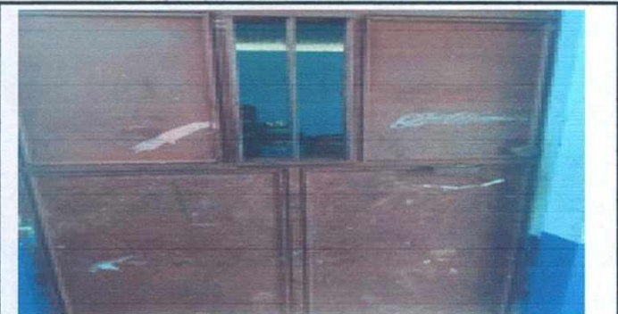
REPARACION Y PINTURA DE PUERTAS DE 3 AULAS Y DOS BAÑOS
