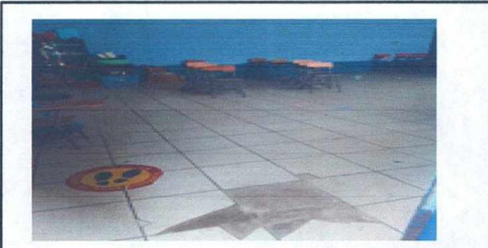
REPARACION DE PISO DE DOS AULAS
