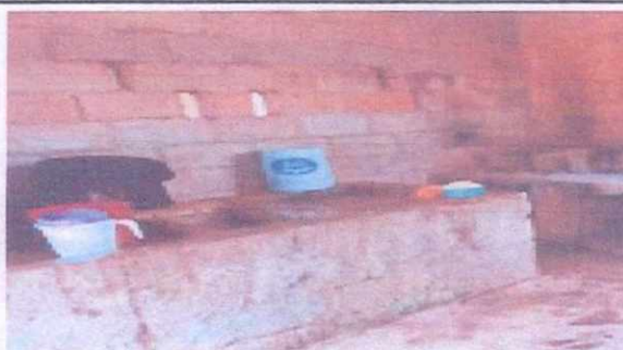
SUSTITUCION DE PILA DE CONCRETO
