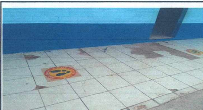
CAMBIO DE PISO DE CORREDOR DE AULAS
