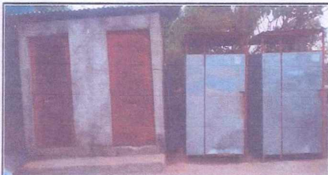
REMODELACION Y CONSTRUCCION DE DOS BAÑOS LAVABLES
