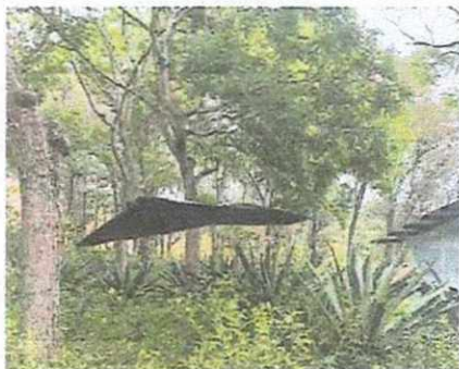
mejoramiento de techo de cocina
