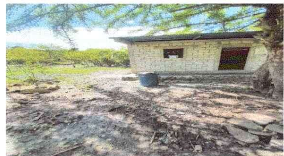
Construcción de deposito de agua
