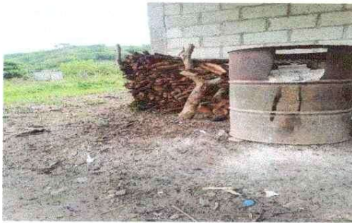
construcción de cocina
