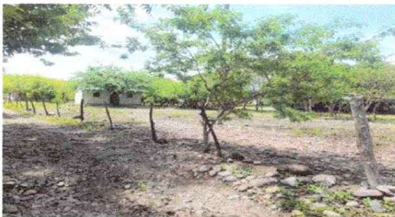
Construcción del Muro Perimetral de la escuela
