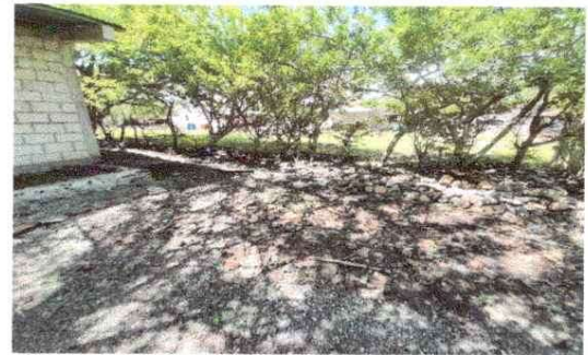
Construcción de Baños
