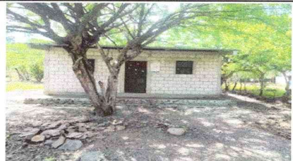
Repello y pintura de la Escuela .
