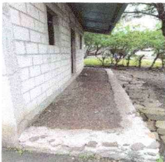
Remozamiento de la cera de la escuela.
