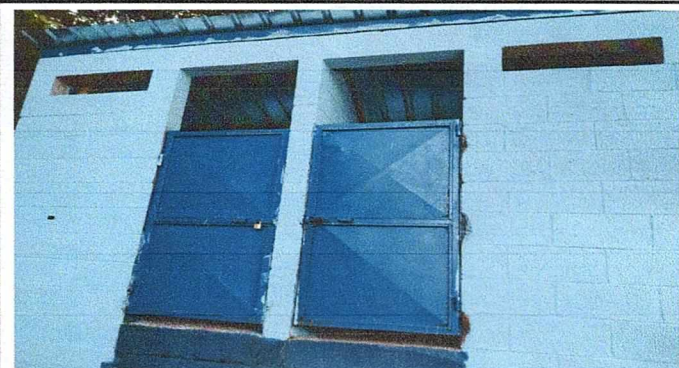
MANTENIMIENTO A ESTRUCTURA
