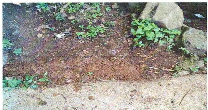
REPARACION DE LA RED DE DRENAJE
