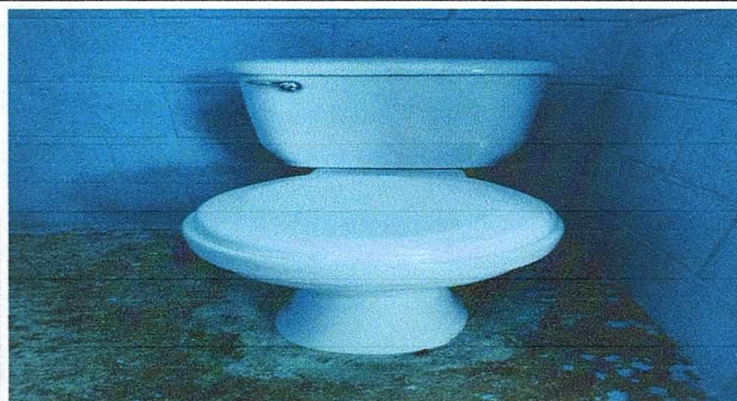
SUSTITUCION DE INODOROS
