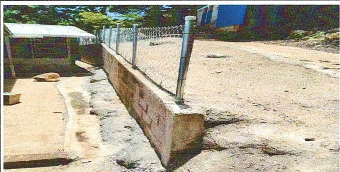
REPARACION DE MURO DE CONTENCION
