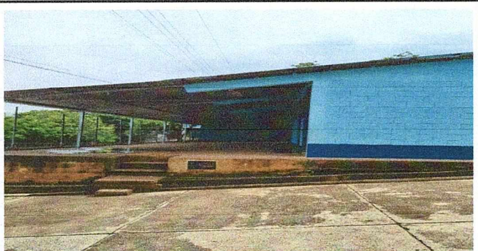
PINTURA EN MUROS INTERIORES Y EXTERIORES
