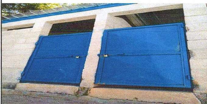
MANTENIMIENTO A ESTRUCTURA
