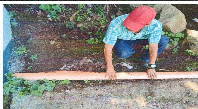
REPARACION DE LA RED DE DRENAJE
