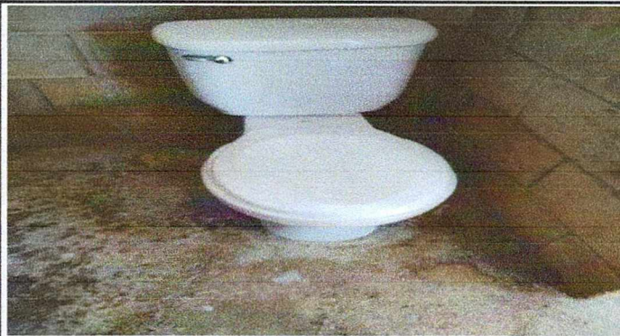
SUSTITUCIÓN DE INODOROS
