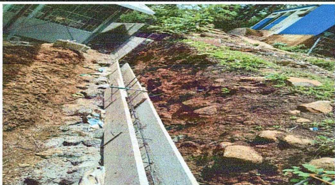
REPARACION DE MURO DE CONTENCIÓN
