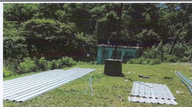
techo de baños
