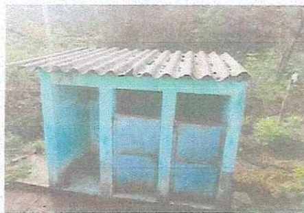
puerta de baños
