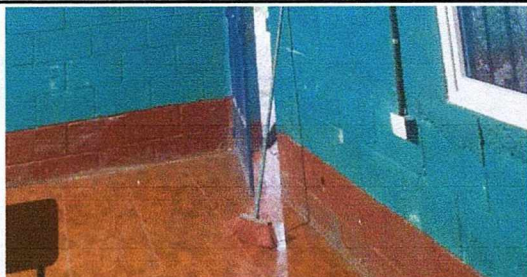
Foto 5: ya se encuentra instalado el piso en todo el salón.
