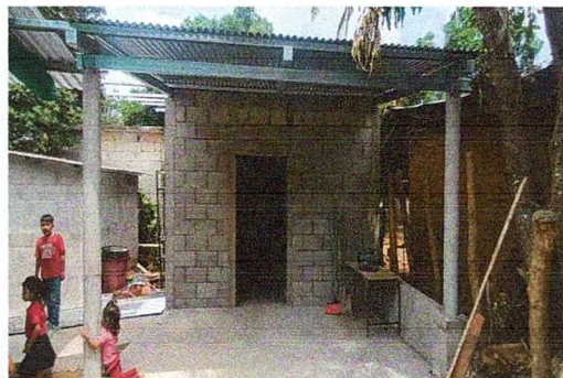
Foto 2: cocina construida en su totalidad.
