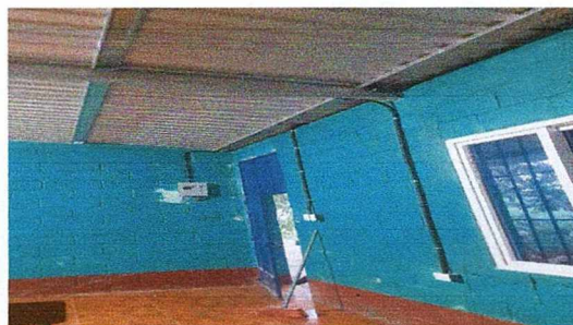
Foto 4: se colocaron cajas de flipones y toda la instalación de energia electrica de nuevo
