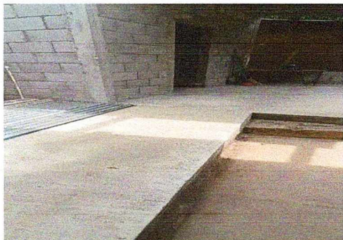
Foto 1: se realizo drejade para poder sacar el agua de lluvia y de consumo diario.
