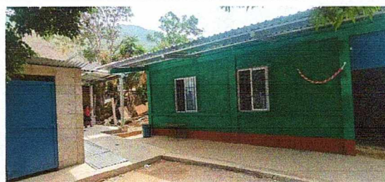
Foto 6: la escuela tiene el nuevo techo, ventanas, pintura y se sellaron las paredes donde se formaron las nuevas ventanas cambio tambien de puerta.
