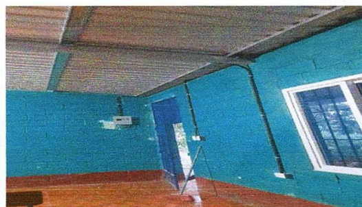
Foto 4: se repara el tendido de energia electrica en el aula
