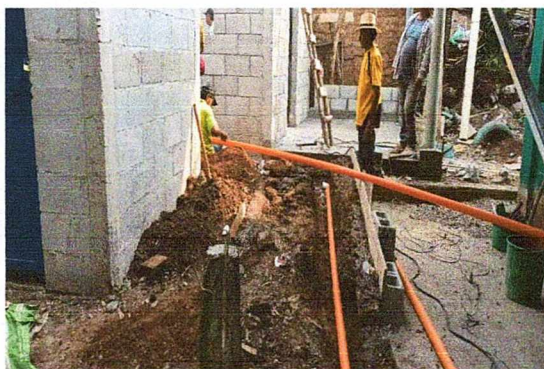
Foto 1: se realizo drejate para poder sacar el agua de lluvia y de consumo diario.
