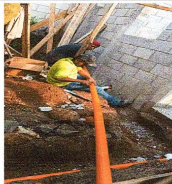
Foto 2: salidas de agua del area de la cocina
