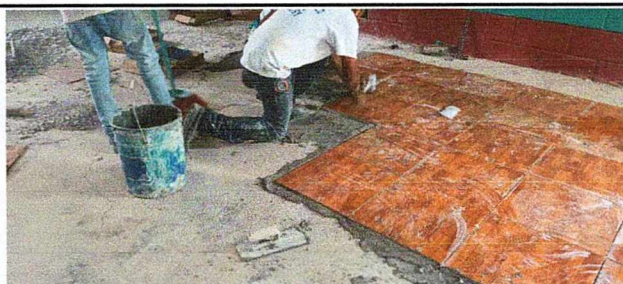
Foto 5: colocación de piso en el aula y tallado de suelo.
