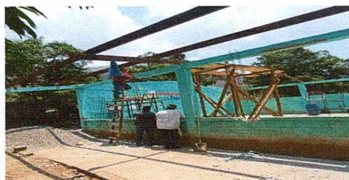
Foto 6: se desmonto el techo y balcones para poder sellar paredes y reforzar, colocacion de columnas.
