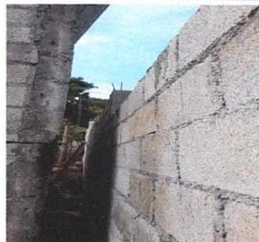
NOTA: Muro Perimetral Lado Norte
