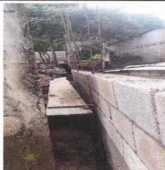
NOTA: Muro Perimetral lado Norte
