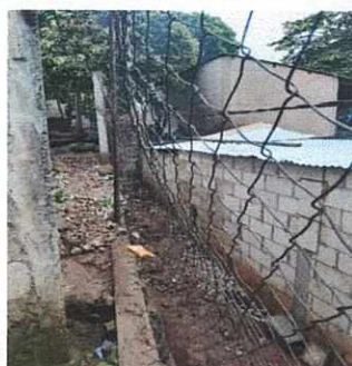
4. Muro perimetral lado norte
