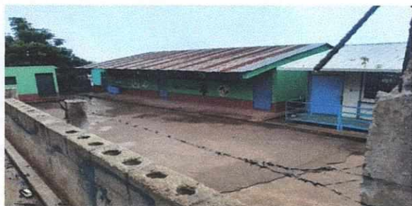
5. Techo de aulas
