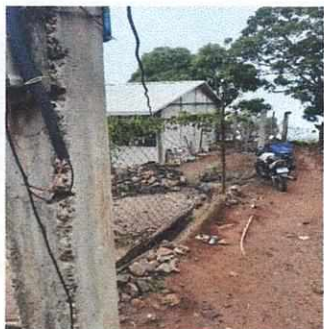
3. Muro perimetral lado sur
