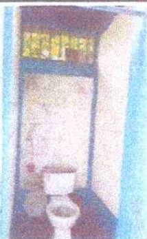
SUSTITUCIÓN DE SANITARIOS Y ACCESORIOS
