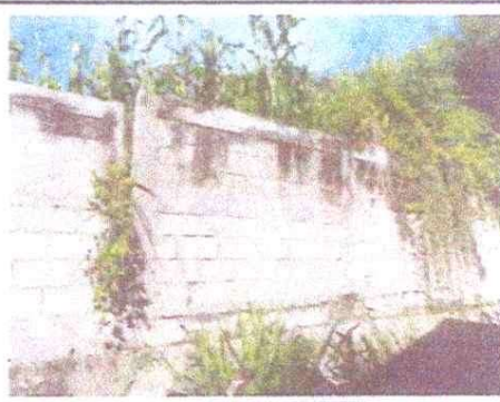
MEJORAMIENTO DE MURO DE CONTENSIÓN
