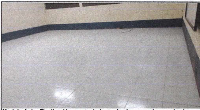
Modulo Aula: Finalización mantenimiento de piso ceramico en el aula
