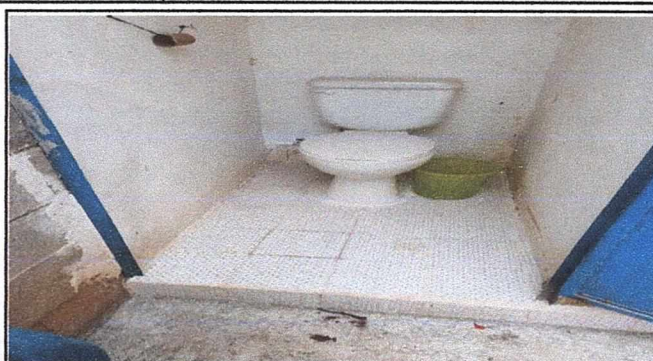
Sanitarios: Finalización cambio de accesorios de inodoro, Mantenimiento de piso ceramico y torta de concreto
