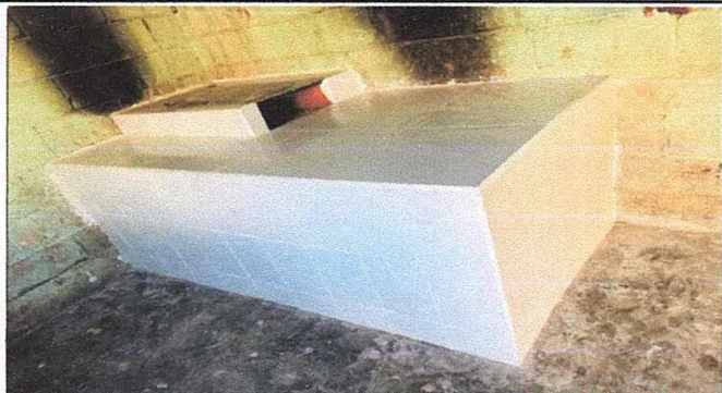
Cocina: Finalización mantenimiento de plancha de metal, ventanas y Azulejo
