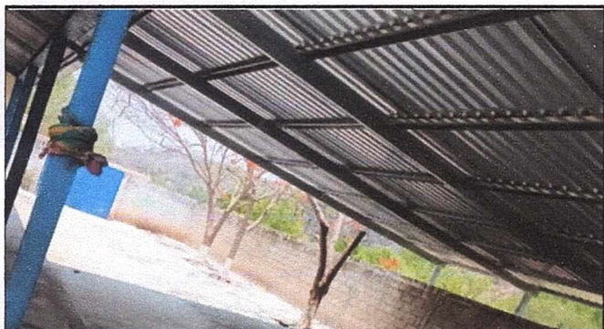
Galera: Finalización mantenimiento de techo y estructura Metalica
