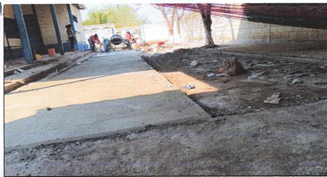
Galera: mantenimiento de torta de concreto
