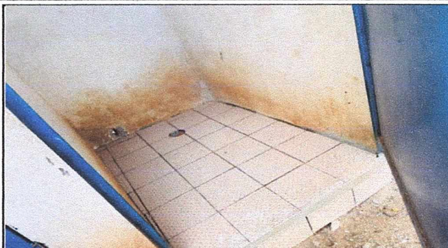
Sanitarios: Cambio de accesorios de inodoro, Mantenimiento de piso cerámico y torta de concreto
