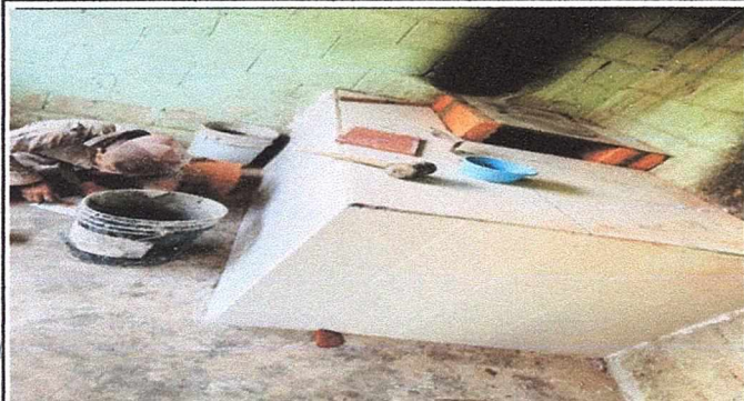
Cocina: Mantenimiento de plancha de metal, ventanas y Azulejo
