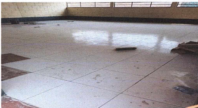
Modulo Aula: mantenimiento de piso ceramico en el aula
