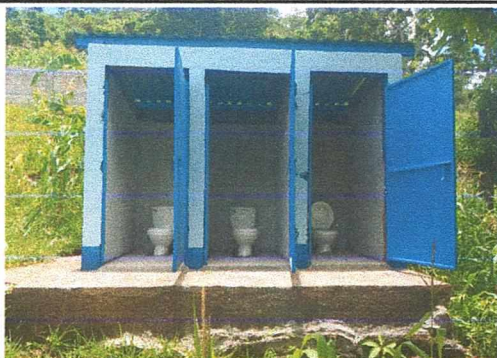
Finalizacion de instalacion de sanitarios, puerta y techo.
