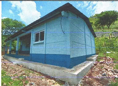
Finalizacion de construccion de banqueta
