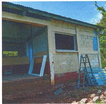
Instalacion de ventanas
