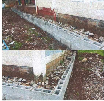
Levantamiento de banqueta.
