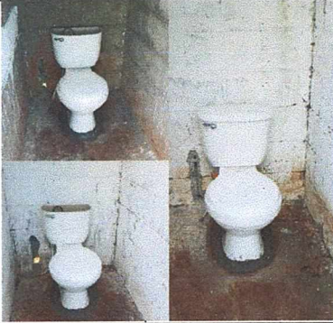
Instalacion de sanitarios
