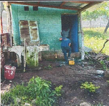
Instalacion de puertas de cocina.
