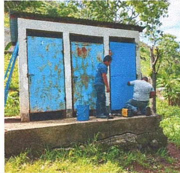
Instalacion de puertas de los baños.
