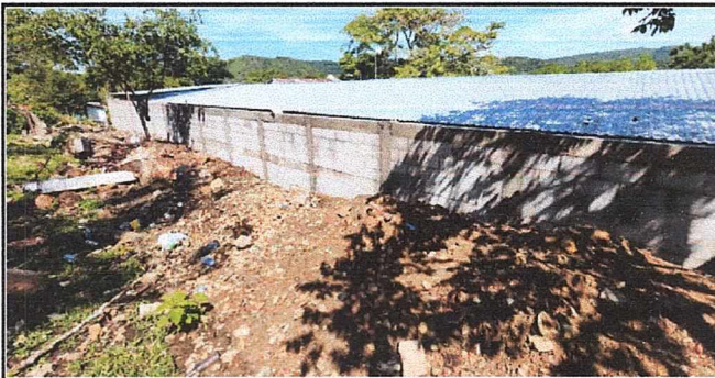
PARTE EXTERIOR DEL MURO PERIMETRAL, ARREGLO DEL TERRENO DONDE SE COLOCÓ EL RIPIO RESPECTIVO.
