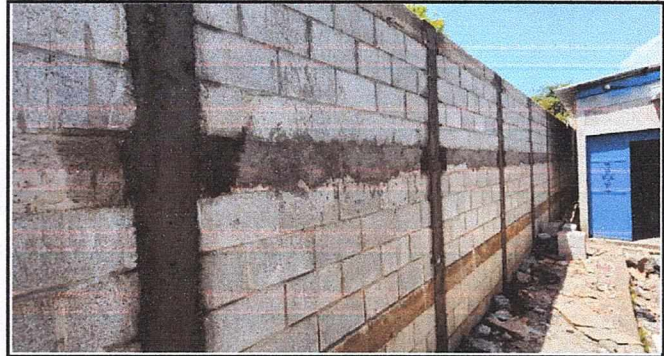
CONSTRUCCIÓN DE COLUMNAS DEL MURO PERIMETRAL
