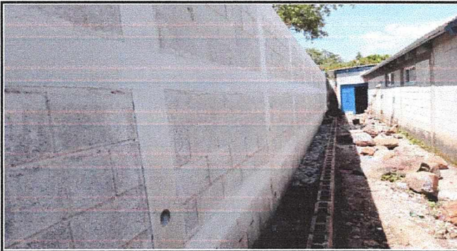
TALLADO DE SOLERAS Y COLUMNAS DEL MURO PERIMETRAL
