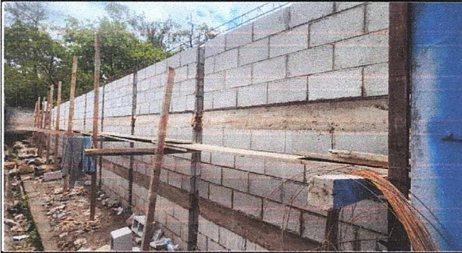
FINALIZACIÓN DEL LEVANTADO DEL MURO PERIMETRAL
