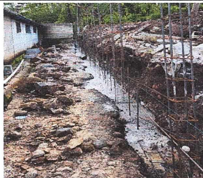
CONSTRUCCIÓN DE SOLERAS DE HUMEDAD DEL MURO PERIMETRAL
