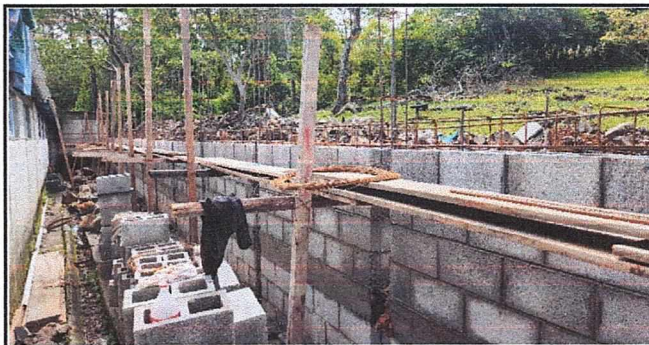
COLOCACIÓN DE HIERRO EN SOLERAS INTERMEDIAS (PARTE 2)
