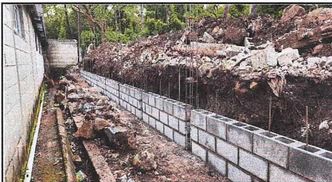
CONSTRUCCIÓN DE MURO PERIMETRAL, LEVANTADO DE HILERAS DE BLOCKS DE 19X19X39 CMS
