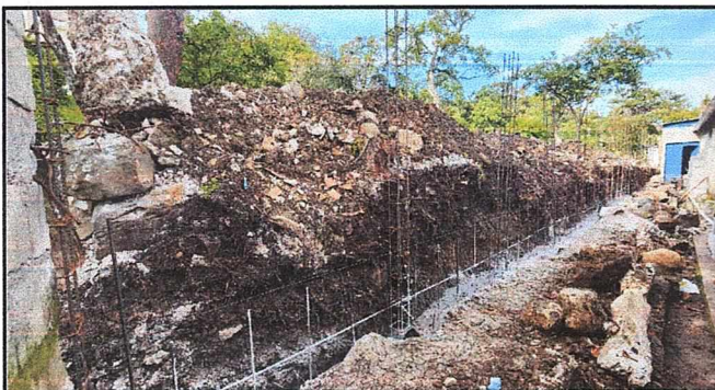
COLOCACIÓN DE COLUMNAS CON HIERRO DE 1/2"
